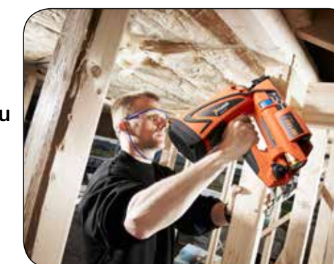
Stavba rámové konstrukce
